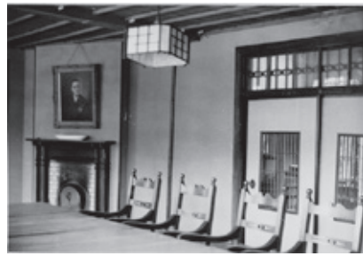
図13 居間北面 暖炉 【客間北壁面】
