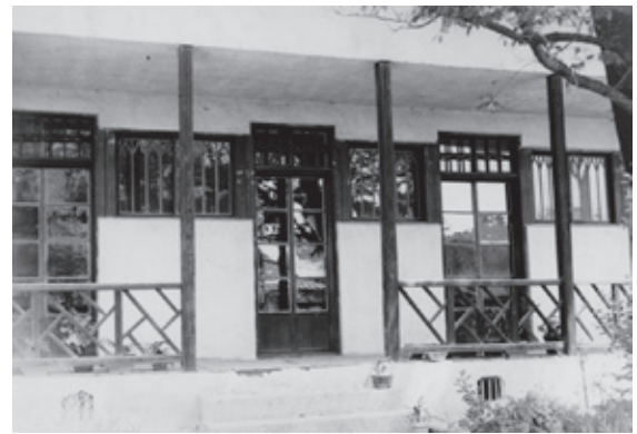
図7 デントン・ハウス外観
