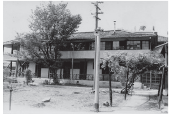
図6 デントン・ハウス外観
